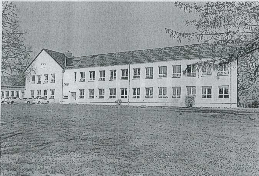
Die Solaranlage auf dem Dach des Staatlichen Förderzentrums in Hainspitz erzeugt seit fast zehn Jahren erneuerbare Energie. Sie war 2013 das erste gemeinsame Projekt des Saale-Holzland-Kreises und der BürgerEnergie Saale-Holzland eG.
